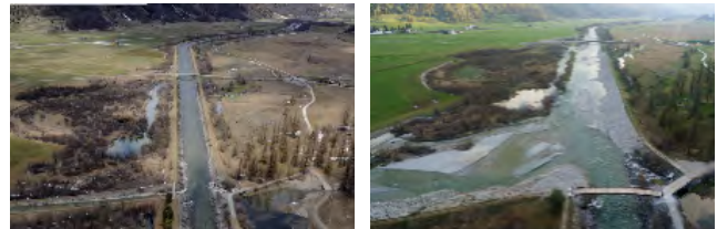
Abb. 46: Die Revitalisierung des Inns bei Bever (GR) ist nicht nur für die Natur, sondern auch fürs Auge eine Erfolgsgeschichte Links: vor der Revitalisierung im Mai 2009; rechts: nach der Umsetzung der ersten Etappe im Mai 2014.
