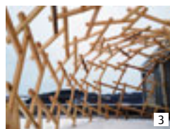
Schnittstellenprojekt 2014/15. Selber programmierte Struktur (reciprocal network) hergestellt mit Unterstützung eines externen Zimmereibetriebs
