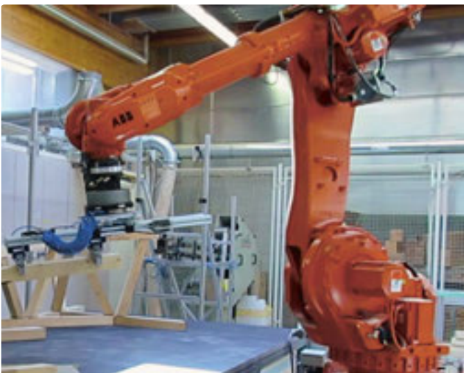
Der Roboter platziert das Element präzise im Bauraum.
